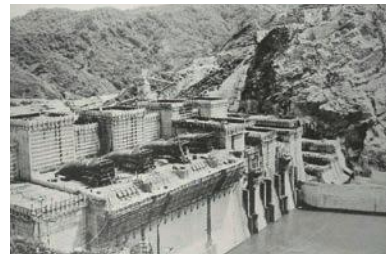
建設中の田子倉ダム(只見町) ▲
