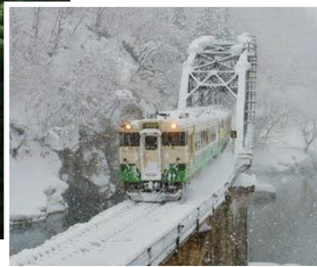
只見川第4橋りょう（金山町）▲
