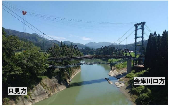
桁架設施工中
